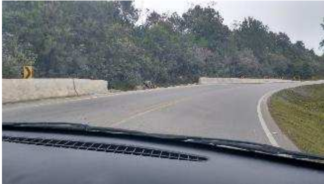
Figura 31: Entrada da curva km 34
