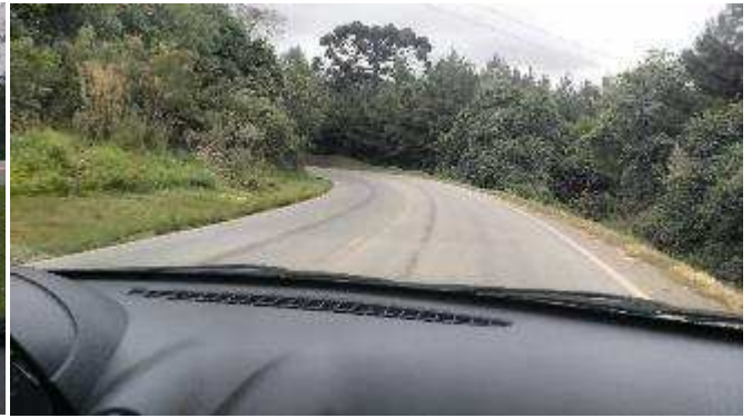
Figura 84: Entrada da 2ª Curva Km 90
