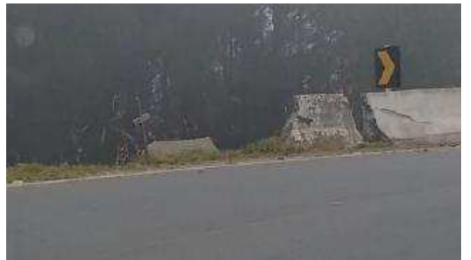
Figura 25: Proteção/barreira destruída
