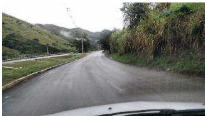
Figura 04: Entrando na rodovia
