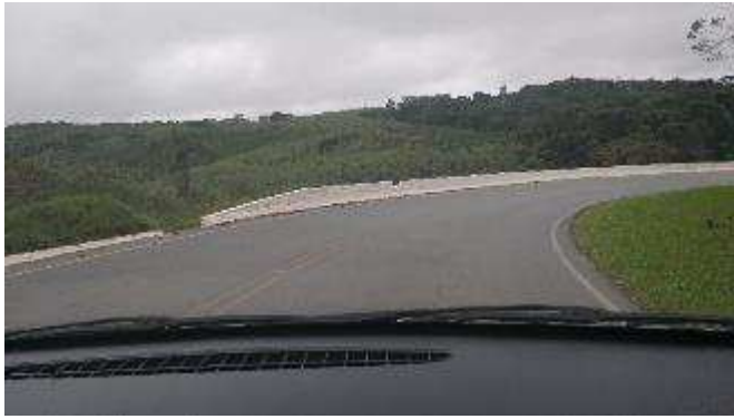
Figura 83: Entrada da Curva Km 90
