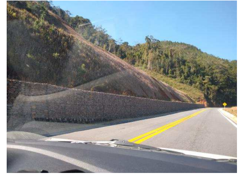
Figura 11: Paredão de contenção de desmoronamento
