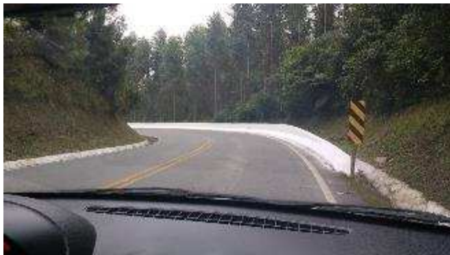
Figura 29: Entrada da curva km 31
