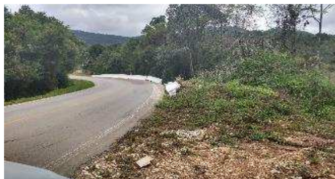
Figura 53: Proteção de pista destruída
