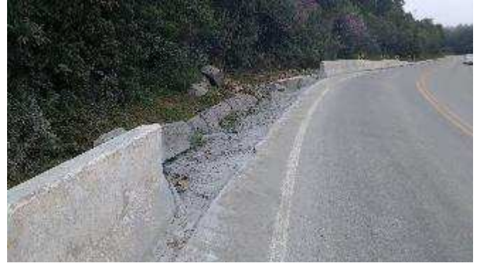
Figura 34: Cimento na espalhado na pista
